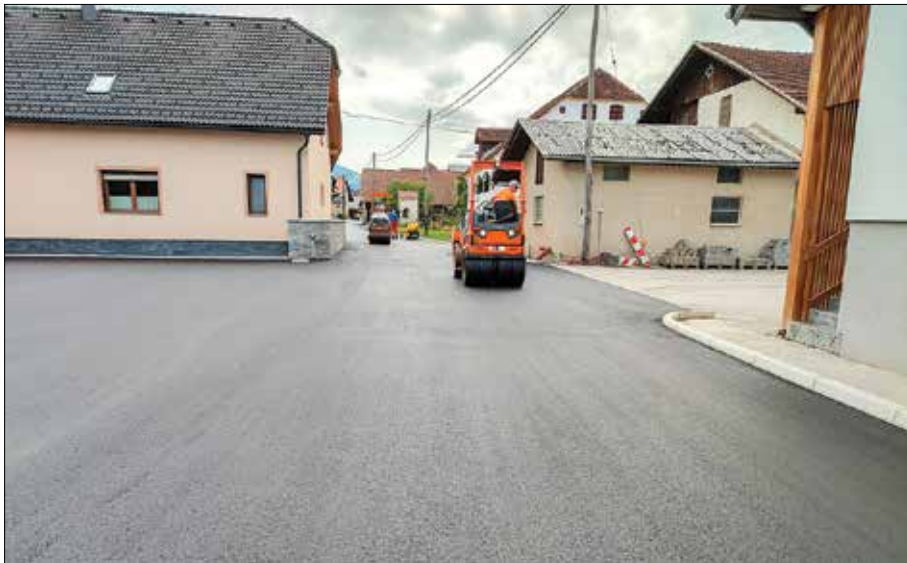
Asfaltna dela so se zaključila konec maja.
